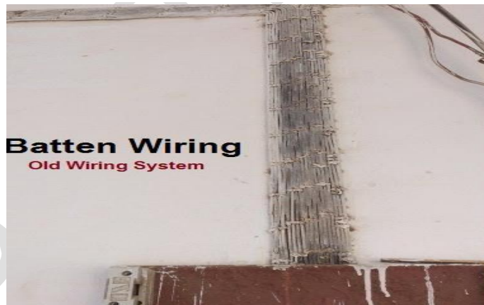
(Fig.5.3. Batten Wiring)
